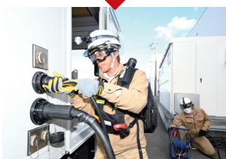
③現場に到着して通電作業に着手
